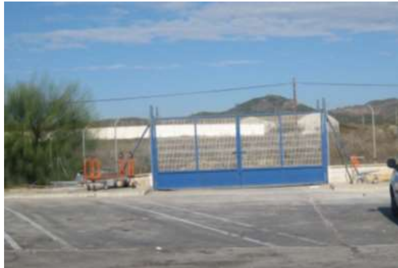
Puerta de salida de emergencia de la parcela en vallado de cara norte
