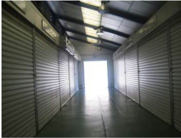
Portón al exterior de nave P-300
