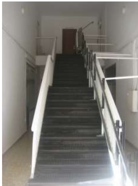
Escalera abierta de acceso a planta alta de edificio comercial
