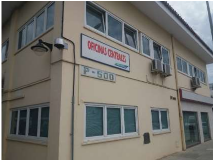
Fachada de edificio de administración
