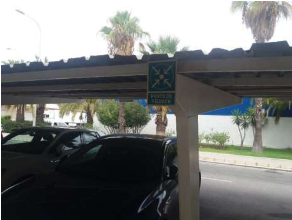
Señalización de uno de los puntos de encuentro
