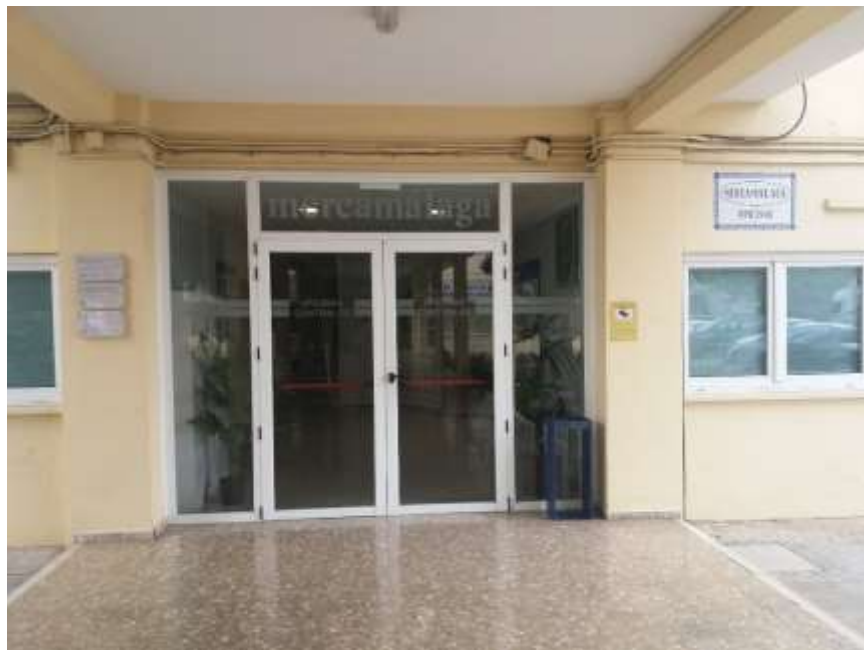
Puerta de entrada a edificio de oficinas
