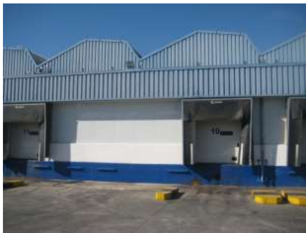
Muelles de carga cerrados mediante paneles frigoríficos en nave de pescado
