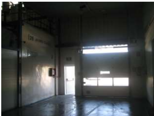
Conjunto de portón enrollable vertical de 3 m. y puerta peatonal de 0.9 m.
