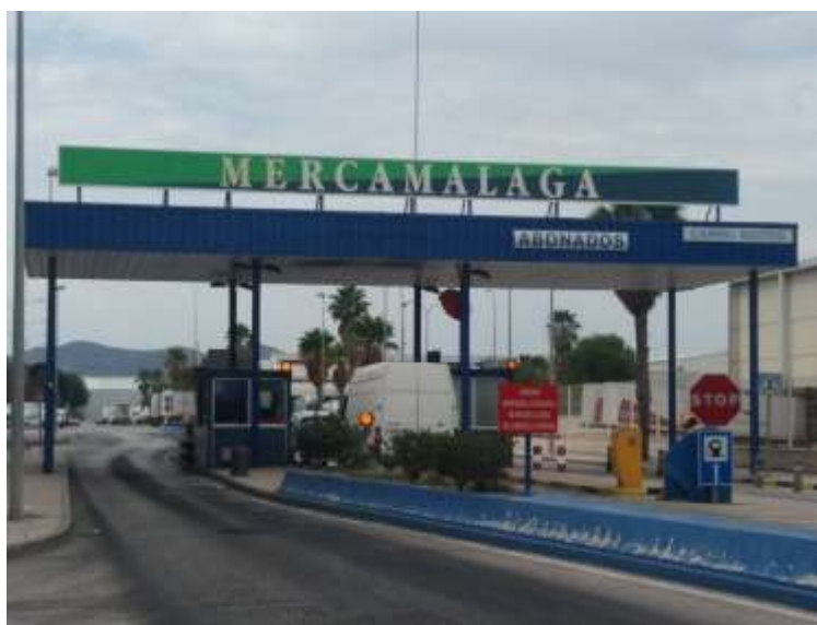
Control de acceso al recinto de Mercamálaga
